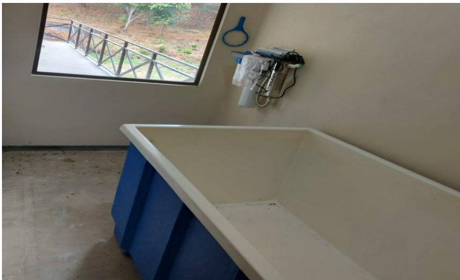
Figura 13. Piscina de depuración.
