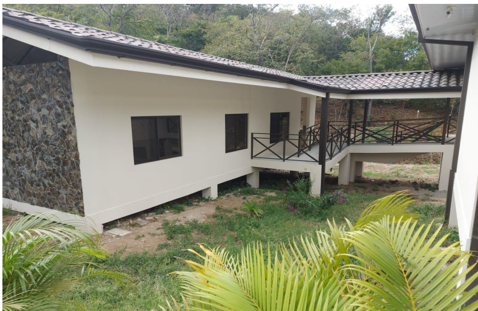
Figura 10. Oficinas administrativas del centro de acopio.
