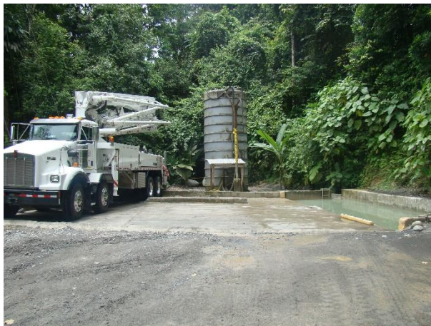
Figura 26. Lavadero de Automezcladora.
