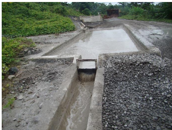
Figura 29. Sedimentadores del Fogón.
