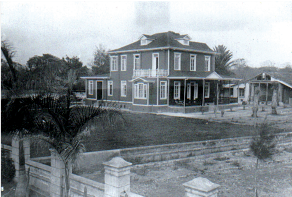
Figura 4. Casa principal de la finca La Caja. 1912. Fuente: Archivo privado
