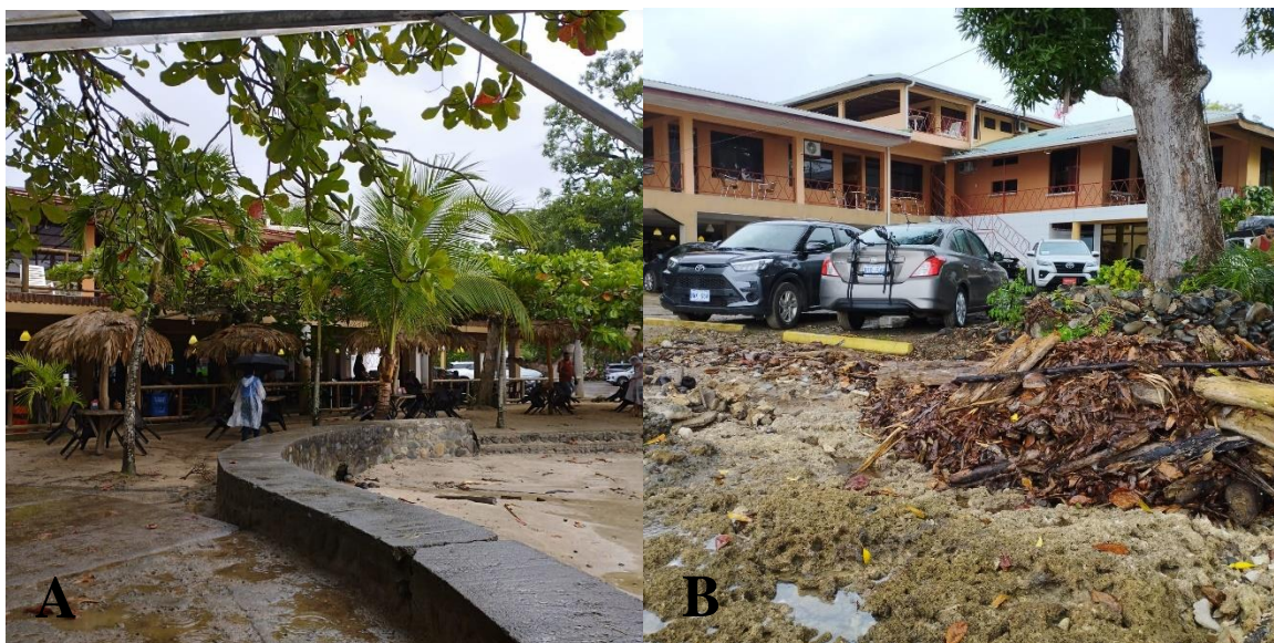
Figura N°2: Fotos representativas de la ficha N°1 y N°2. Se puede observar en la foto A la presencia de un muro como obra de mitigación a causa del proceso de erosión y en la foto B es posible observar la exposición de raíces y la plataforma de coral en el parqueo del hotel.
