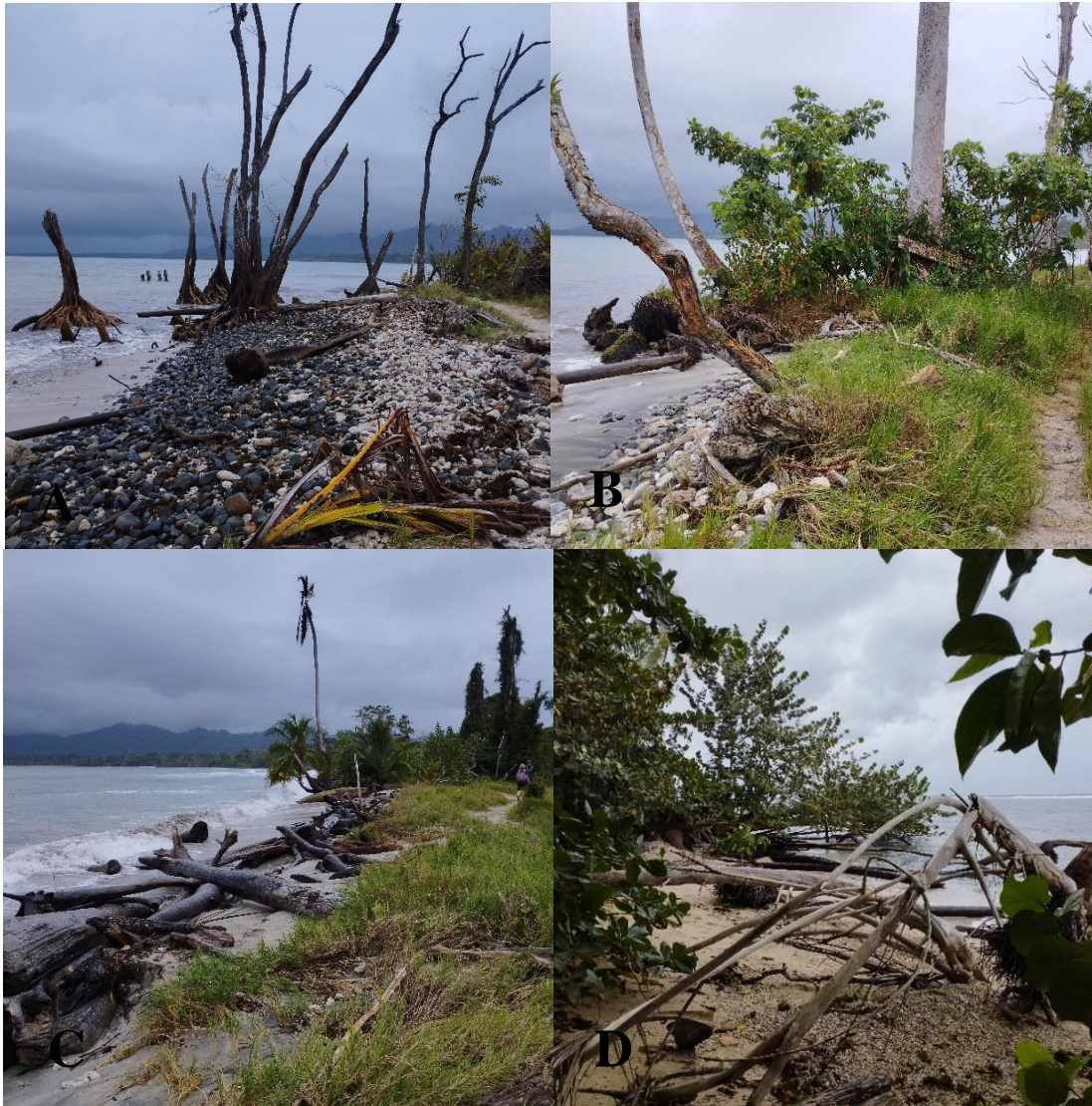
Figura N°13: Fotos representativas de las fichas N°14 a la N°15. Se observa en las fotografías adjuntas deposición de sedimentos (A), pérdida del sendero, desaparición del camino y el paso es un poco difícil como consecuencia (B), retroceso y pérdida de la vegetación (A y C), palmeras y árboles caídos, así como retroceso de la playa (D).
