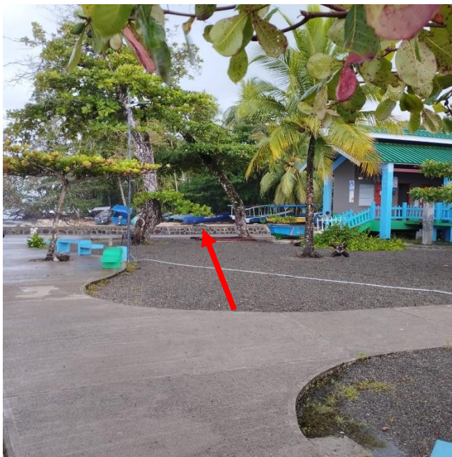
Figura N°7: Foto representativa de la ficha N°7. La fotografía adjunta muestra la obra de protección que construyeron alrededor de la infraestructura del muelle.
