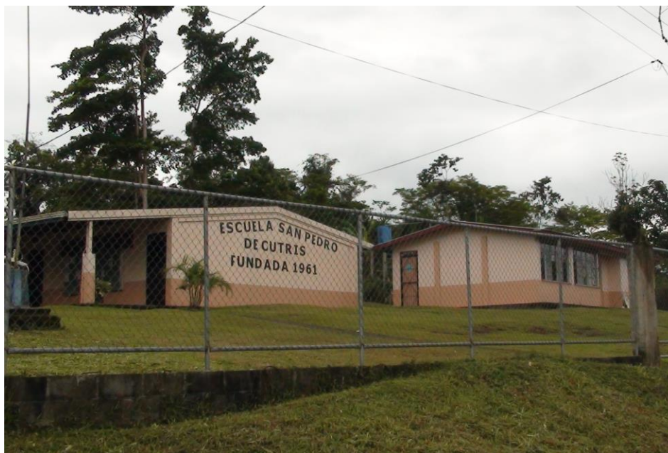
Figura 9. Escuela San Pedro de Curtis, San Carlos.
