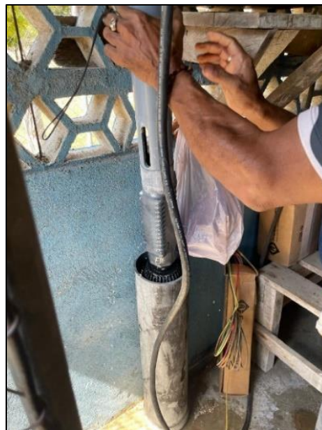
Figura 2.6. Sistema de cloración en tanques.
