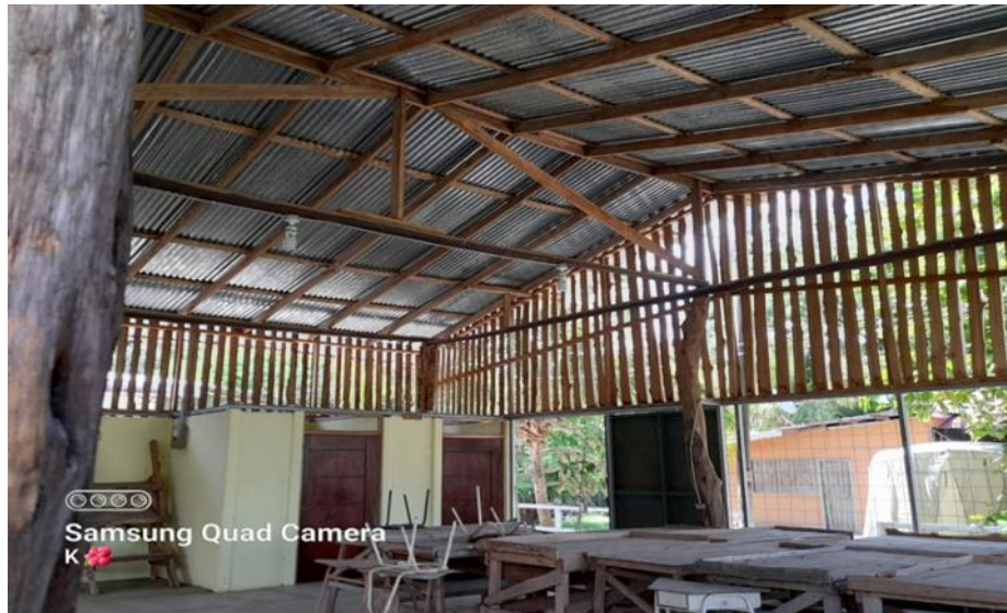
Figura 9 Interior de la construcción del centro de agronegocios
