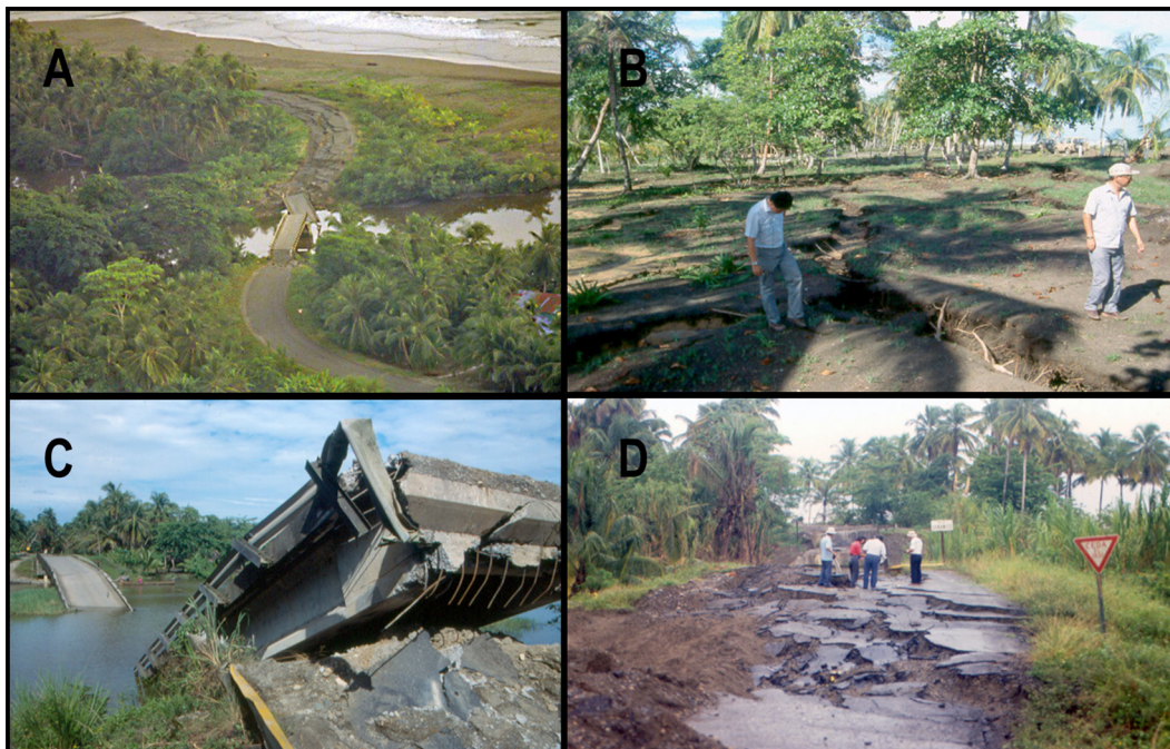
Fig. 8: Licuación, separación lateral y subsidencia en las cercanías de la desembocadura del río Bananito. A: Aspecto del colapso del puente, separación y agrietamiento del terreno en los alrededores del puente del río Bananito; 3 de mayo de 1991. B: Terrenos en la margen izquierda del río Bananito, cerca de su desembocadura. C: Puente colapsado del río Bananito. D: Licuación, agrietamiento y separación lateral de la carretera y rampa de aproximación del puente sobre el río Bananito. Fotografías tomadas por Sergio Mora Castro el 11 de mayo de 1991.
