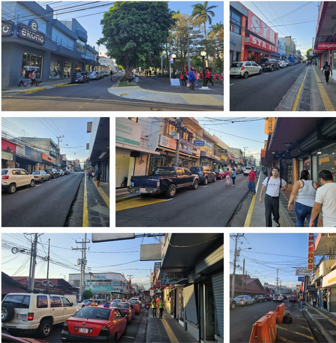
Figura 91. Distrito de Heredia, Calle 2, Ave. 0 – 8, 2024
