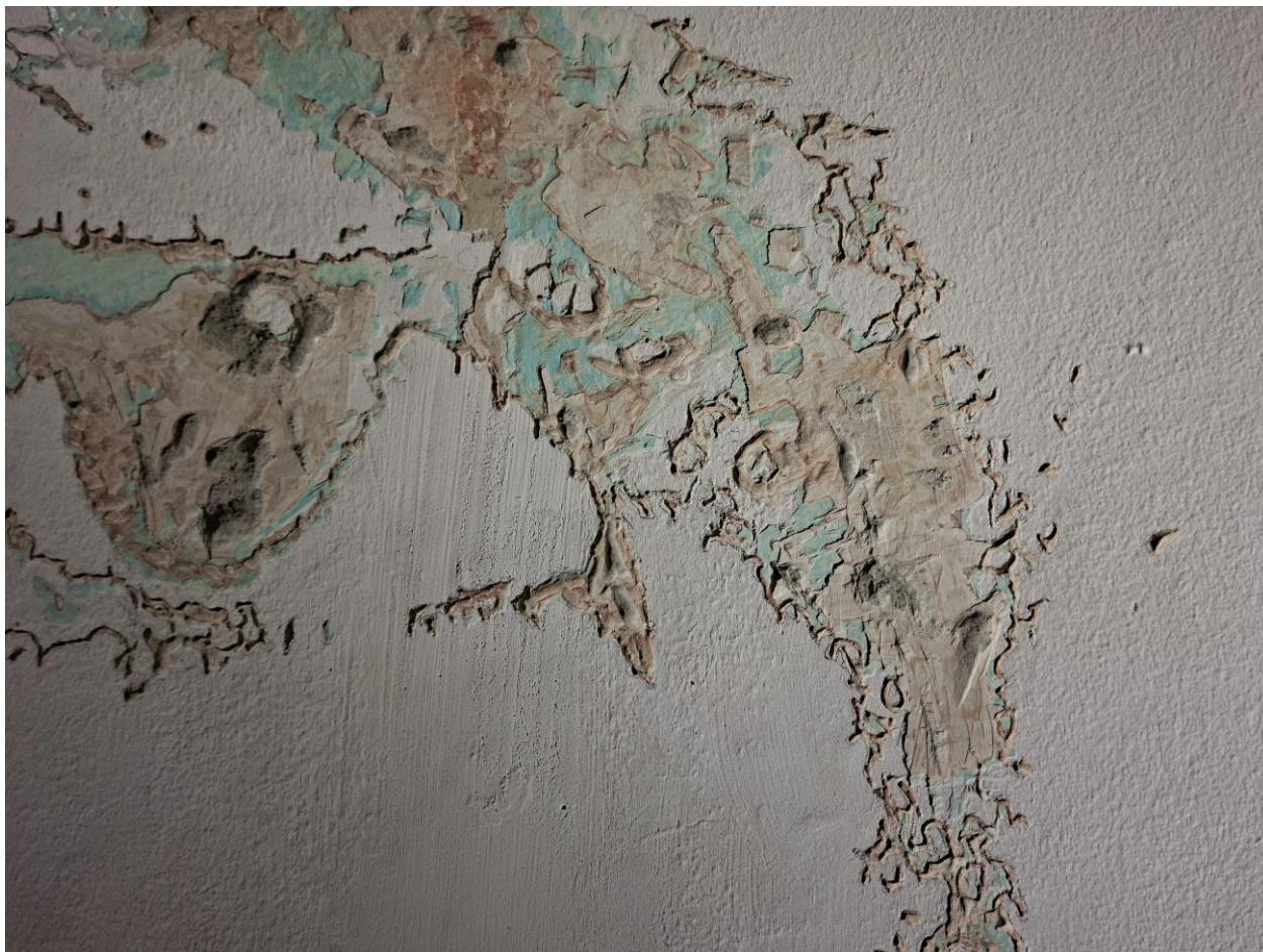
Figura 82 Detalle de Obra.
