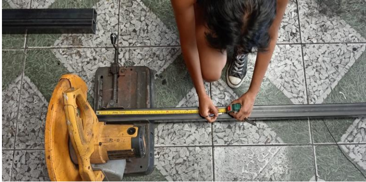
Figura 55 Corte de tubos galvanizados a medida
