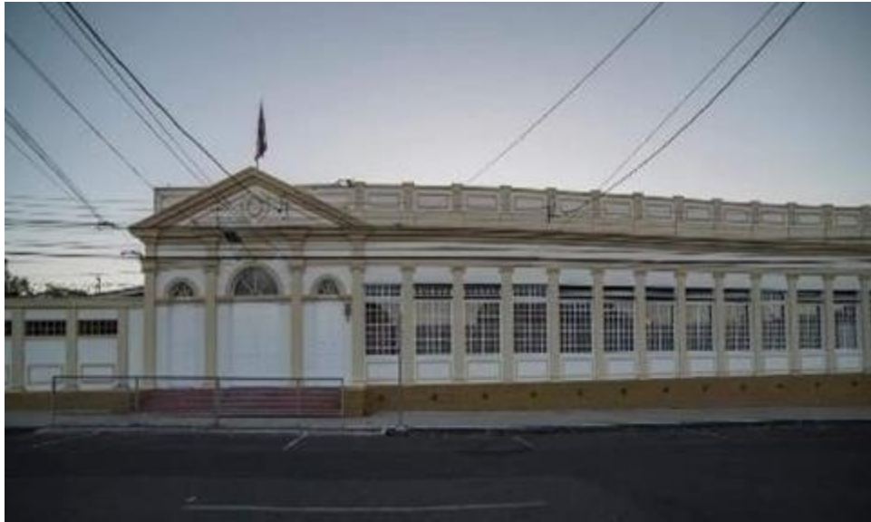
Representa la entrada principal de la Escuela Ascensión Esquivel Ibarra ubicada en la provincia de Cartago.
