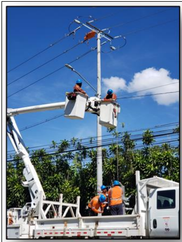
Figura 4 Instalación de equipo. Nota. Fotografía tomada del Procedimiento de trabajos en líneas energizadas hasta 34.5 kv bajo la técnica “a contacto con la mano enguantada” (2023).
