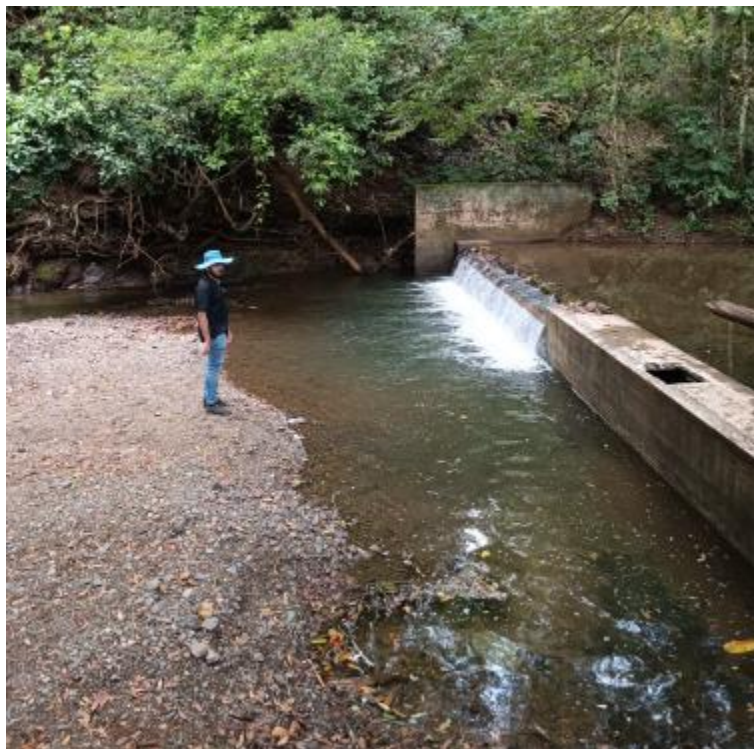
Figura 6.12. Toma de agua para potabilización y consumo humano. Fuente: Araya, 2023
