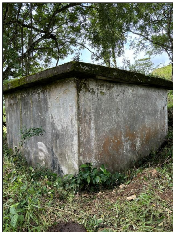
Figura 6. 16. Terreno posible ubicación del tanque de almacenamiento del acueducto de Los Andes de La Cruz, Guanacaste.
