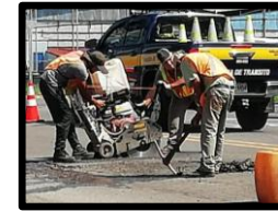
MANTENIMIENTO DE CALLES
