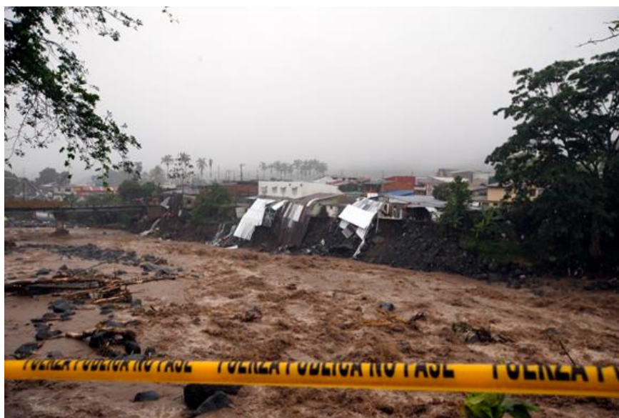
Figura 6. Emergencia año 2021, cantón de Turrialba, por desborde del río Turrialba
