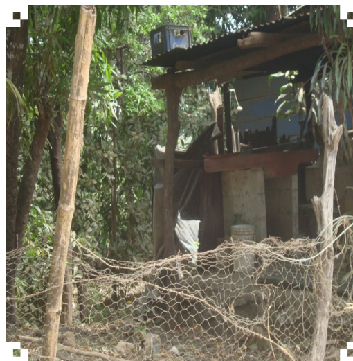
Foto 3. Viviendas al margen del río Sequito en Paraíso.
