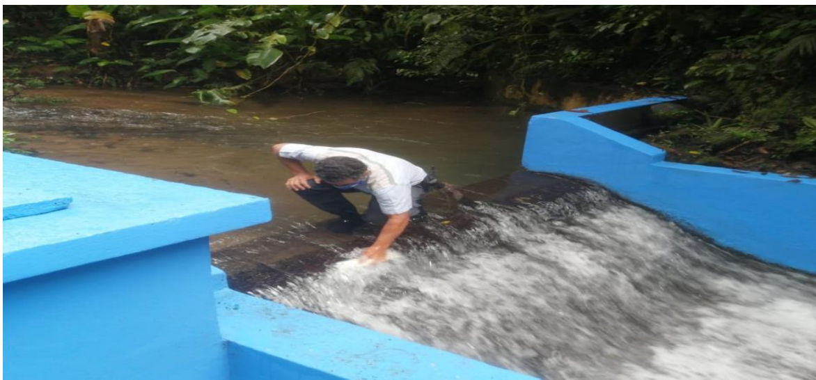
Figura 9. Operador de la planta potabilizadora de La Paz, San Ramón brindando mantenimiento a la toma de agua.
