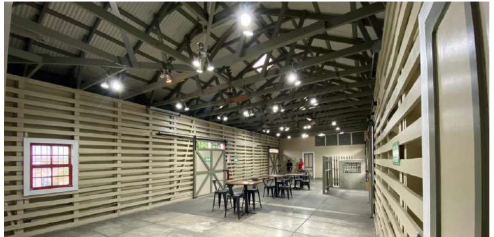
Figura. 44 Detalle de vigas internas
