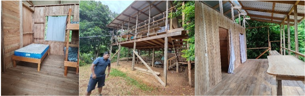
Instalaciones del emprendimiento de turismo cultural Se Siwá Eco Lodge. Fuente: Karla Murillo, 2024.
