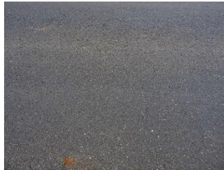
Imágenes 5, 6, 7 y 8. Transición material de la Calle Breña Mora, de lastre a asfalto y concreto.
