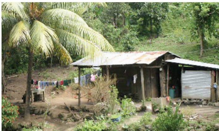
Figura 18. Vivienda en condiciones precarias
