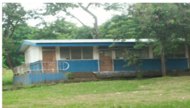
Figura 9. Escuela Primaria en La Escoba
