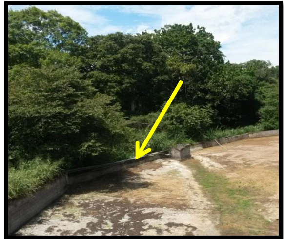
Figura 32. Tuberías utilizadas para captar el lixiviado en el patio de tratamiento de la pulpa residual en el Beneficio de Coope- Atenas, 2015.
