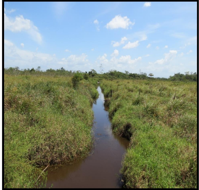
Figura 36. Canal de avenamiento para habilitar en agricultura zonas de humedal
