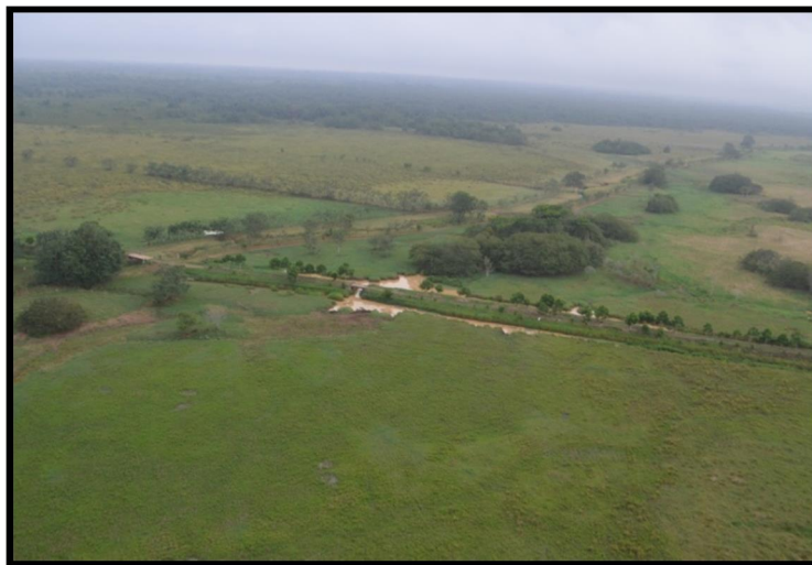
Figura 23. Construcción de puentes y rellenos levantados para el paso de ganado dentro del humedal
