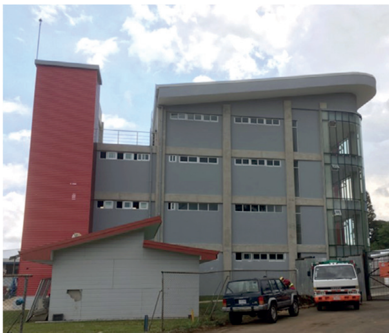
Figura 3. Vista lateral del nuevo Edificio de Física Médica Aplicada.
