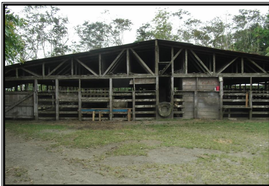
Figura 3. Instalaciones utilizadas para el trabajo de campo.
