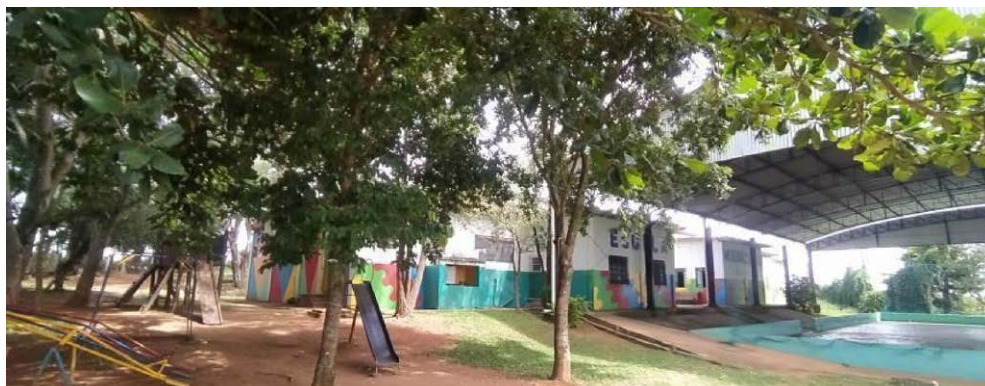
Figura 7- Lateral da Escola Municipal Orlando Paulino da Costa, no bairro rural Muzambo, Alfenas.
