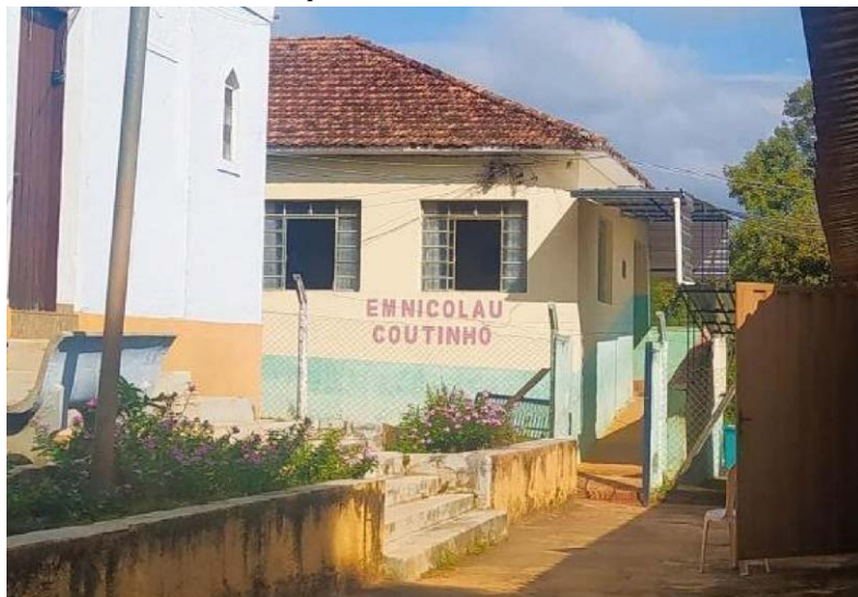
Figura 6- Lateral da Escola Municipal Nicolau Coutinho, no bairro rural Bárbaras, Alfenas.
