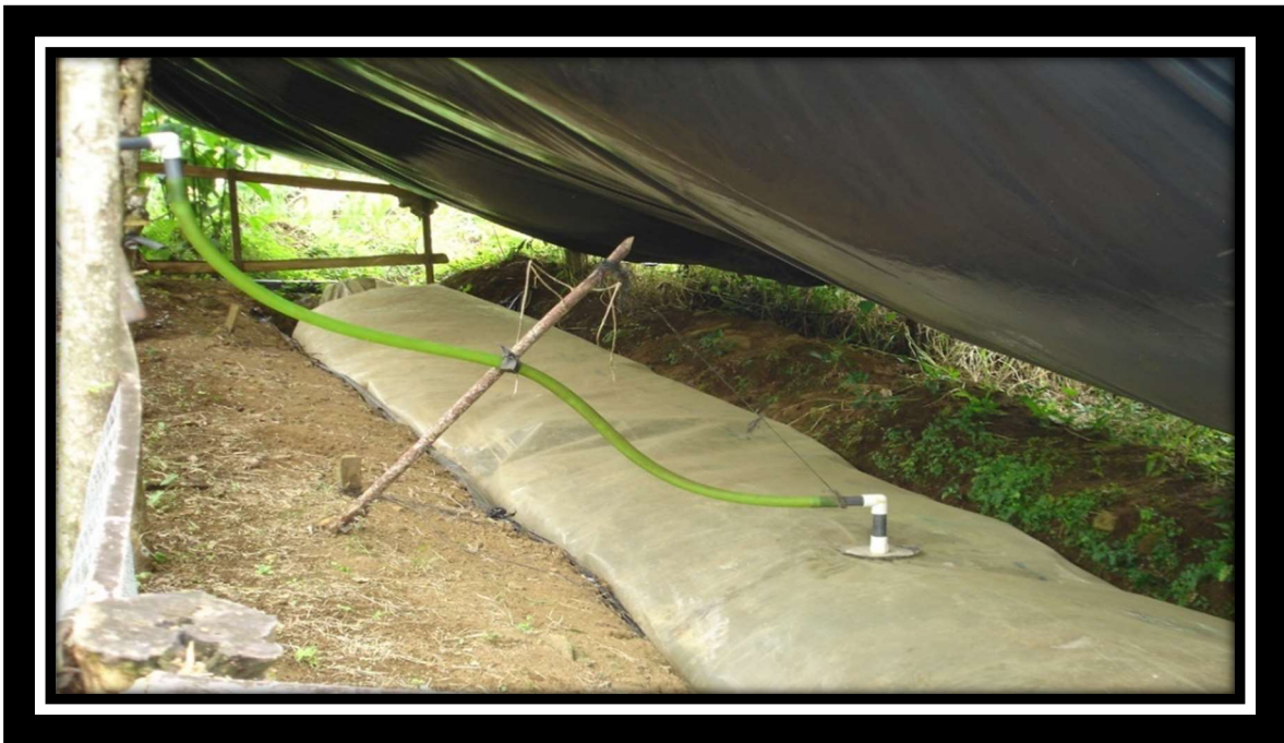
Figura 2. Biodigestor implementado en Finca ecológica del Atlántico Costarricense.
