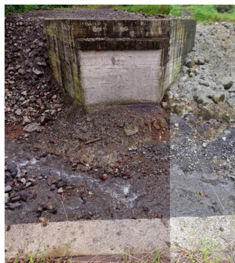
Imagen 3: Base puente en construcción
