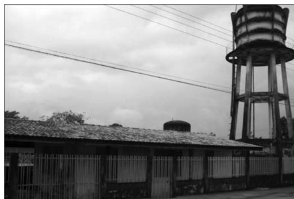
Foto 8. Instalações da CAESA em Oiapoque
