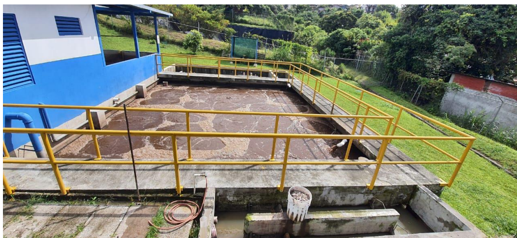
Figura 2.1. Planta de Tratamiento de aguas residuales en estudio ubicada en San Rafael de Heredia, Costa Rica.
