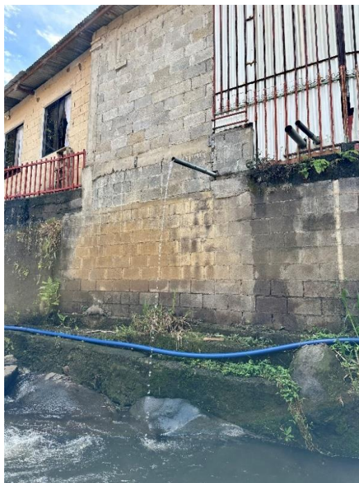
Figura 6.7. Punto de vertido directo por parte de viviendas aledañas en el cuerpo receptor.
