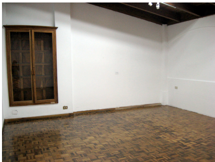
21. Vista siguiendo a la derecha
