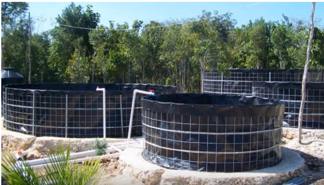
Fuente: Tanques de geomembrana
