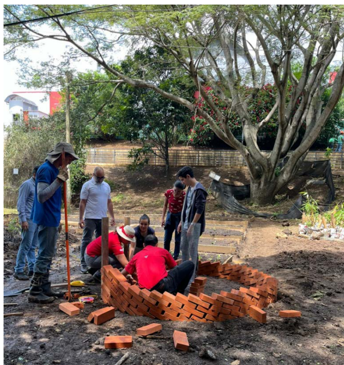
Figura 43. Construcción de keyhole en el huerto universitario del Campus Omar Dengo, Heredia.
