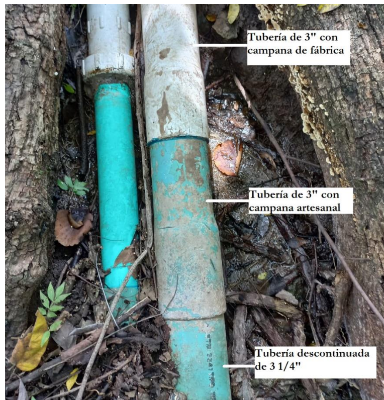
Figura VI.8. Reparación artesanal en tuberías de diámetros no estandarizados
