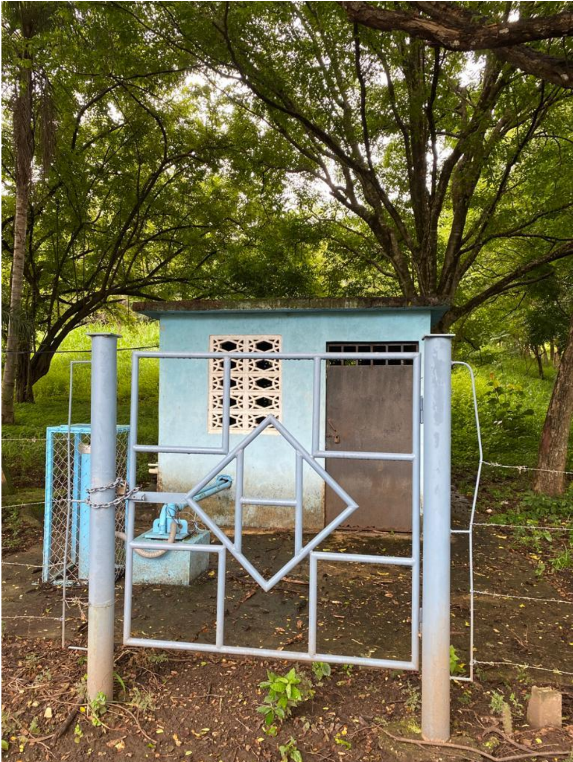
Anexo 3. La fuente de abastecimiento de la comunidad de Peñas Blancas, Colorado, el cual es la fuente de abastecimiento de agua.
