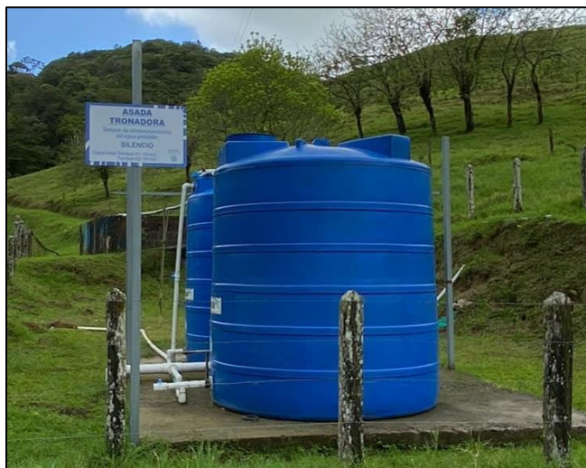
Figura 6.8 Condición actual de los Tanques I y II El Silencio.
