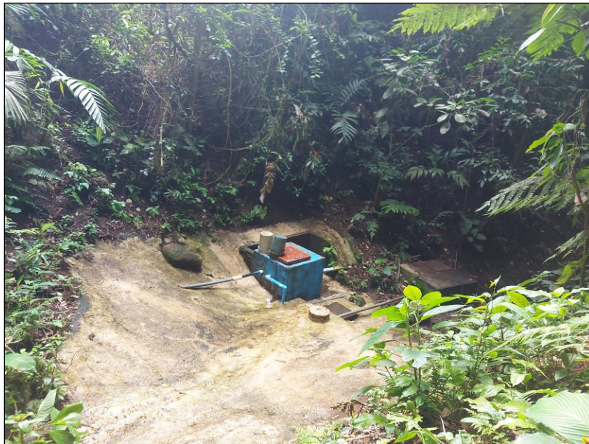
Anexo 6.12 Naciente Alberto González con ausencia de malla de protección.
