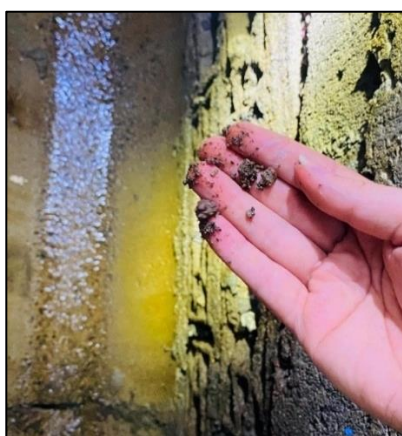
a) Sedimento cayendo de la infraestructura del sistema de captación.
