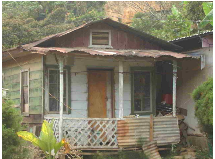
Muchas recolectoras “ngöbe” habitan en baches en malas condiciones, sin servicio sanitario, sin baño y sin privacidad.
