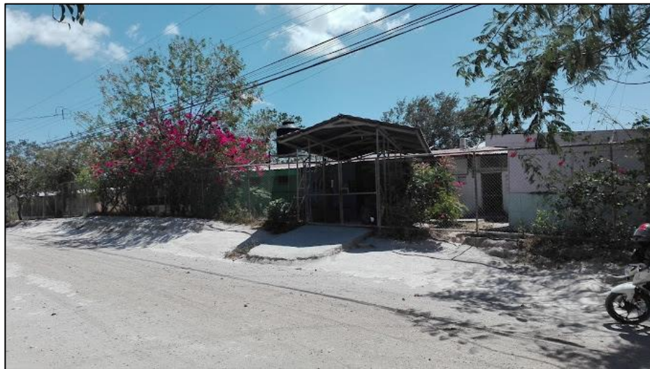
Figura N°8. Escuela Jesús de Nazareth (Antigua construcción).
