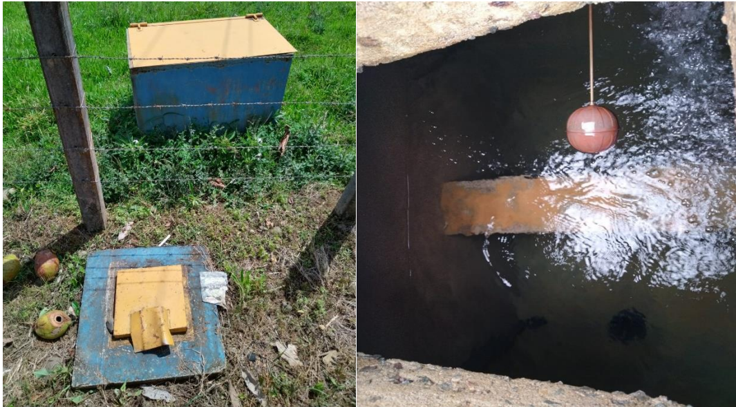
Figura 6.11. Estructuras quiebra gradiente en la línea de distribución del acueducto de Altamira.
