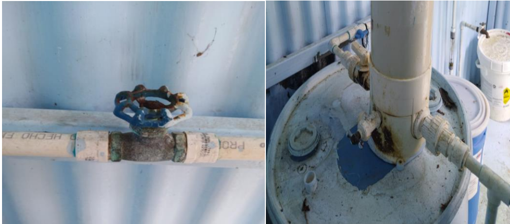
Figura 6.9. Componentes desgastados o deteriorados del sistema de cloración del sistema de Altamira
