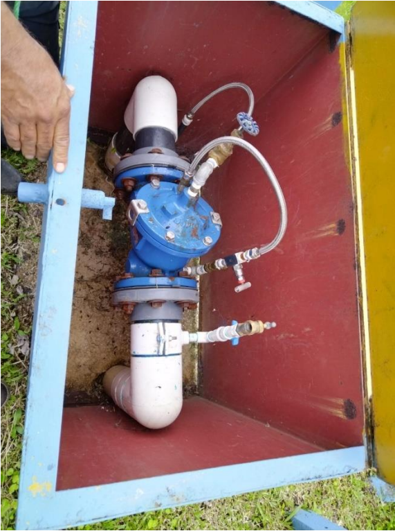
Anexo 3. Válvulas controladoras de presión en la red de distribución del sistema de Altamira
