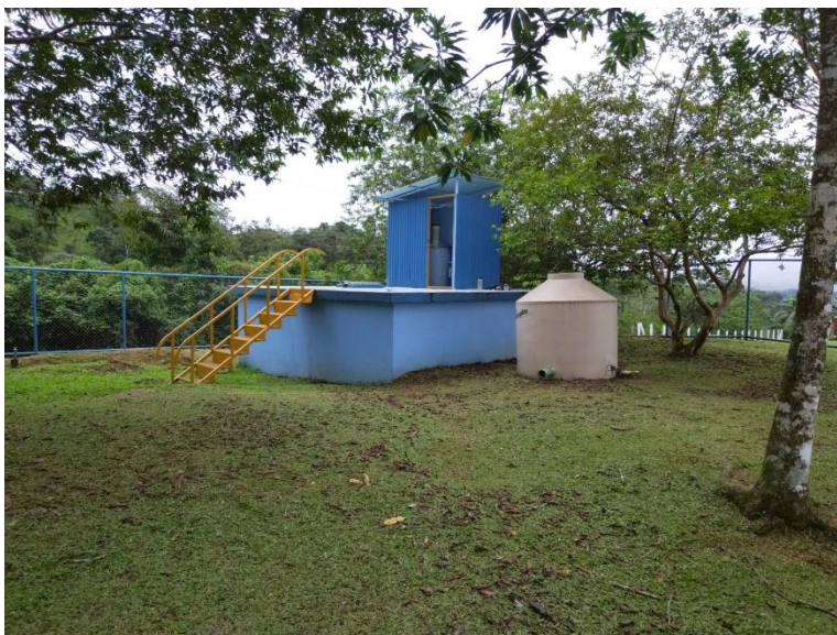
Figura 6.7. Tanque de almacenamiento del subsistema de Altamira de la ASADA Bijagua
