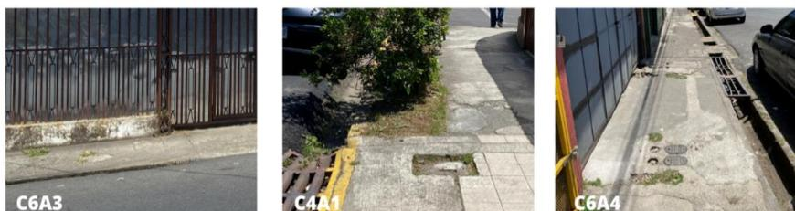
**Figura 47.** Ejemplos de bacheo, huecos, desnudamiento y grietas en las aceras C6A3, C4A1 y C6A4 de Curridabat.
