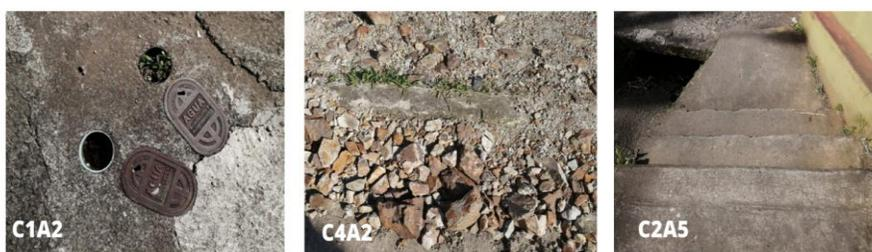
**Figura 48.** Ejemplos de huecos, sedimentos y escalonamiento en las aceras C1A2, C4A2 y C2A5 de Monte Verde.
