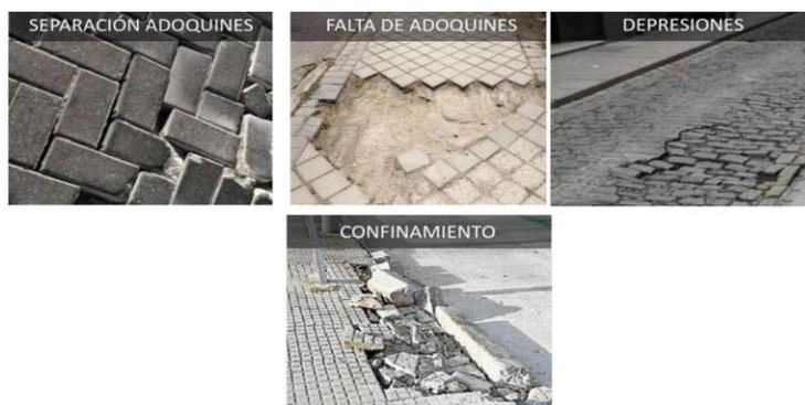
**Figura 11.** Separación, falta de adoquines, depresiones y confinamiento como irregularidades comunes en aceras de adoquín.
