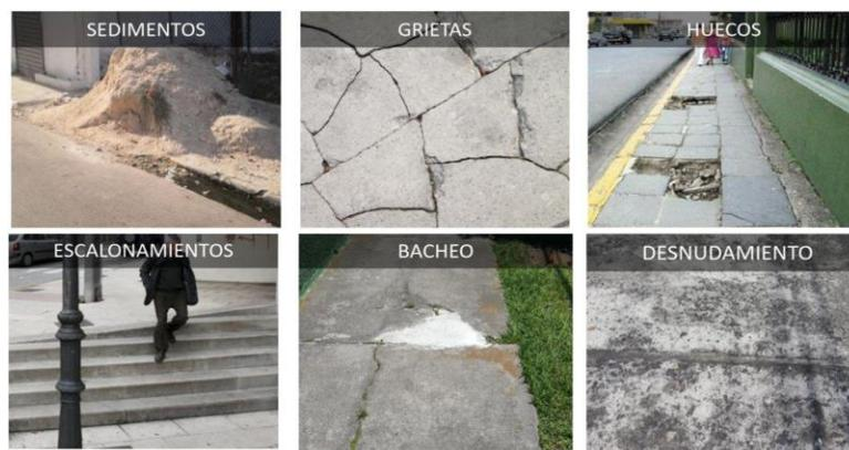
**Figura 10.** Sedimentos, grietas, huecos, escalonamientos, bacheo y desnudamiento como irregularidades comunes en aceras de concreto.
