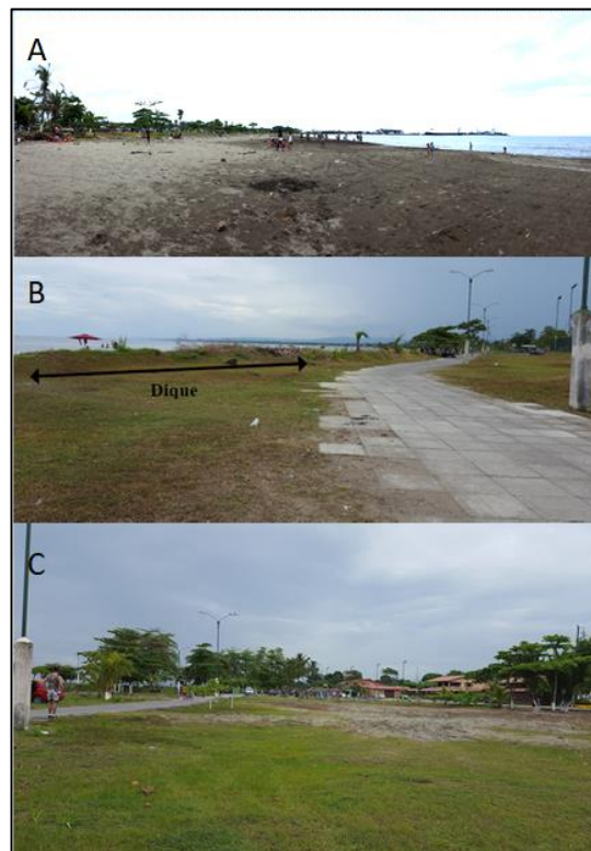
Figura 3. Fotos del sitio 1. A) Sitio donde se levantan los perfiles. B) Obra de mitigación (muro de tierra) construida para proteger el bulevar de la inundación marina durante oleajes severos. C) Depósitos de washover que muestra el alcance de olas durante tormentas extremas. Elaboración propia.
