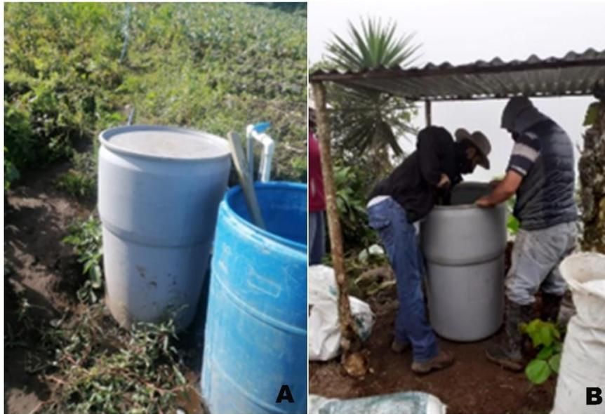
*Figura 30.* Ejemplos de instalación de biocamas: (A) biocama al aire libre cercana a fuentes de agua; (B) biocama bajo techo.
