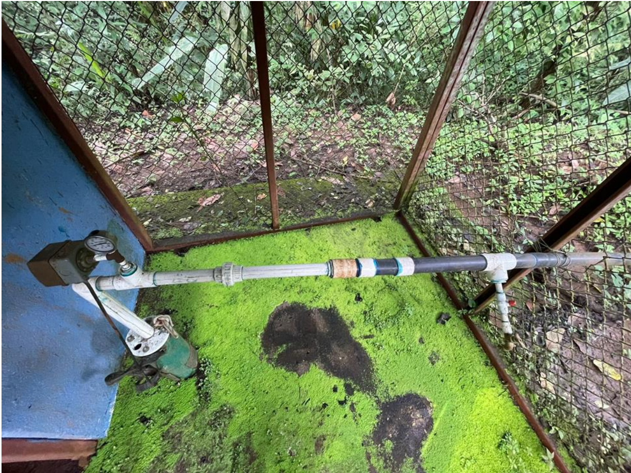
Figura 14. Cachera de descarga del pozo de Juan Díaz.
