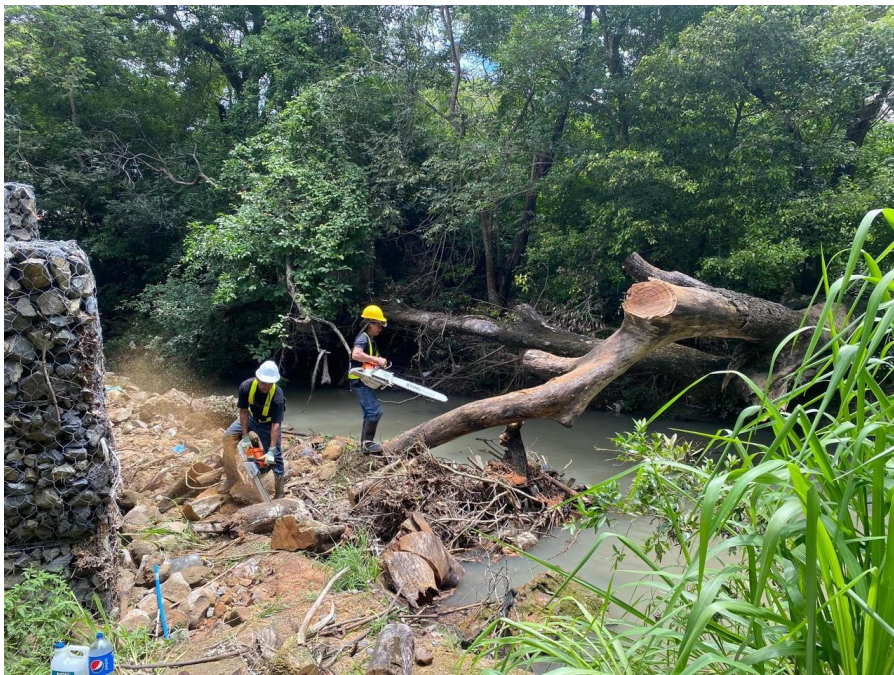
Figura 6.28. Evidencia de los trabajos de corta y extracción de troncos secos y árboles caídos en el cauce del río Liberia por parte de la Unidad de Gestión Ambiental.
