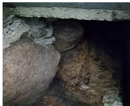
Figura 35. Vista de las paredes internas del tanque
