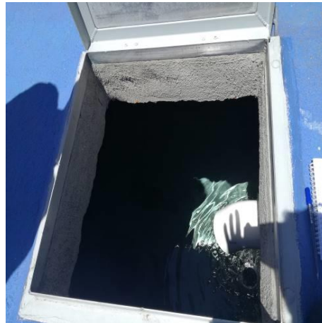
Figura 45. Revisión interna del tanque
