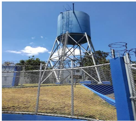
Figura 54. Malla perimetral del tanque y pozo
