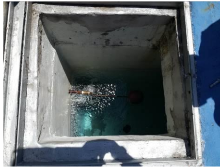
Figura 48. Paredes internas en concreto liso
