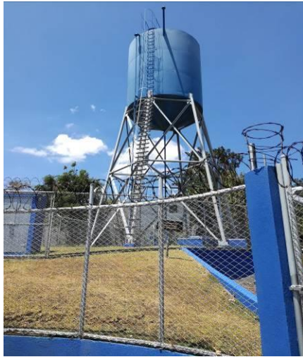
Figura 12. Vista de la estructura del Tanque Doña Elena
