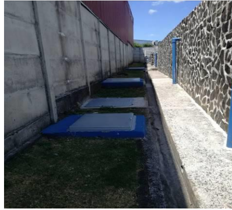
Figura 47. Tapas sin óxido y cerradas
