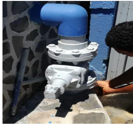
Figura 43. Revisión de tuberías
