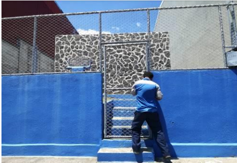
Figura 6. Malla perimetral en buen estado
