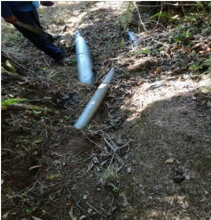
Figura 38. Tubería expuesta
