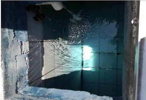
Figura 7. Revisión de limpieza de tanques
