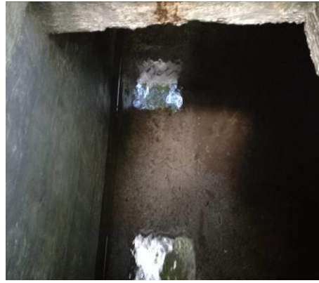
Figura 33. Vista de las paredes internas del tanque
