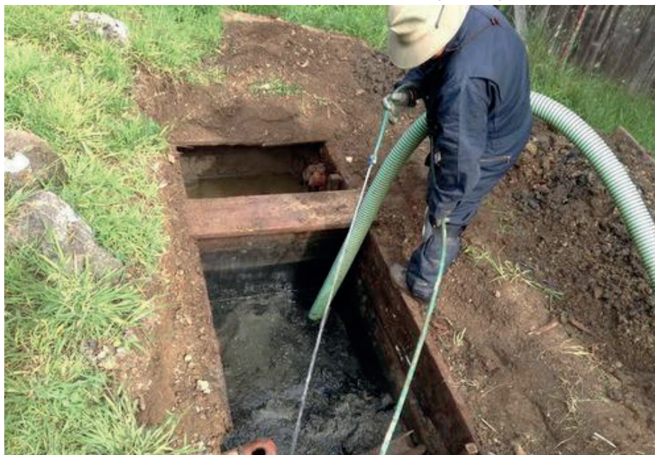
Figura 3 Extracción de lodos de un tanque séptico
