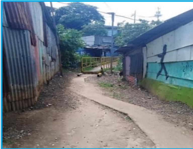
Puente Cuenca Sur-La Milpa
