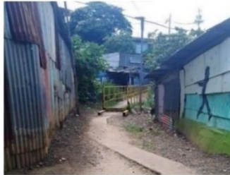
3. Puente Cuenca Norte-La Milpa
