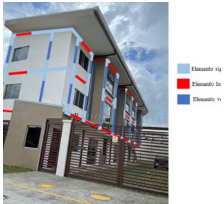
Figura 1. Método del marco equivalente aplicado sobre viviendas agregadas en San José (Costa Rica).
