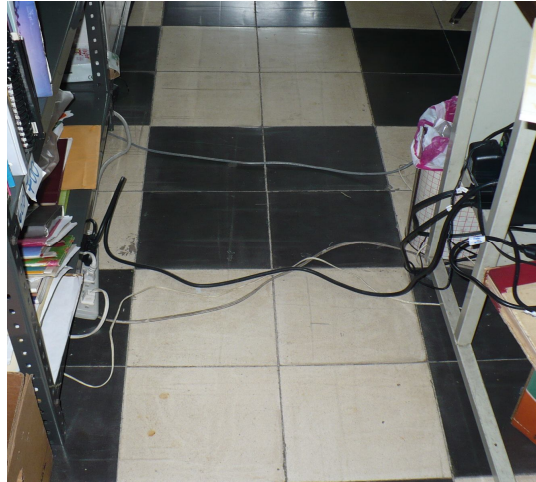
Figura No. 29: Cables de electricidad obstruyendo el paso
