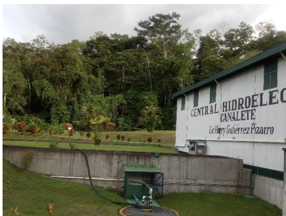
Figura 2.24. Central Hidroeléctrica Canalete.
